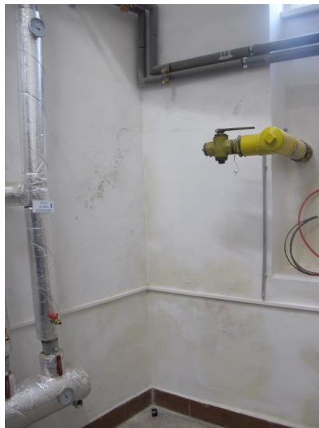
Foto č.6 – vlhkostní mapy s odpařovací zónou s prostupem plynovodního potrubí v prostoru výměňkové stanice
