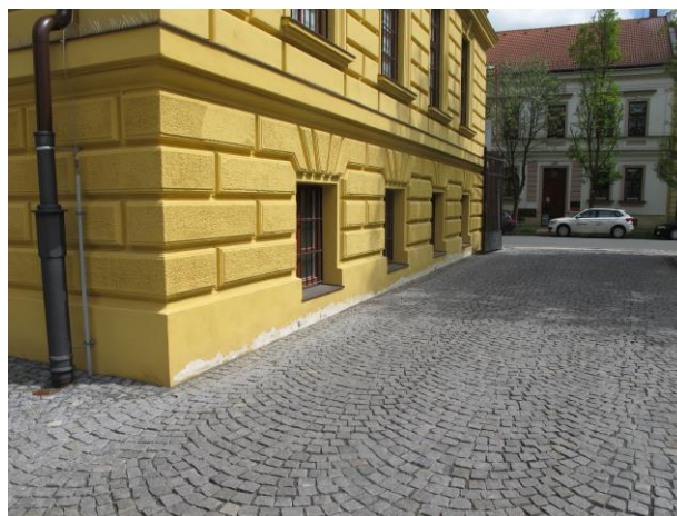
Foto č.2 – vliv zasolení od zimní údržby na soklových omítkách při vjezdu do areálu z ulice Opletalova
