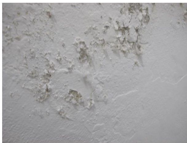
Foto č.8 – detail destrukce omítek
