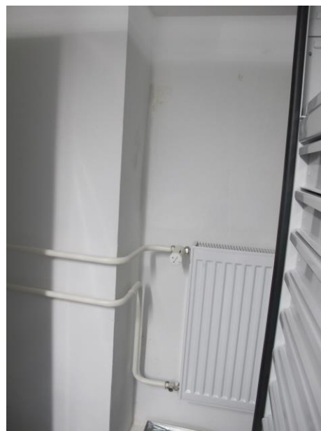
Foto č.12 – prostupy solí pod úrovní stropu vč. sprásování maleb v návaznosti na sádkartonové obložení
