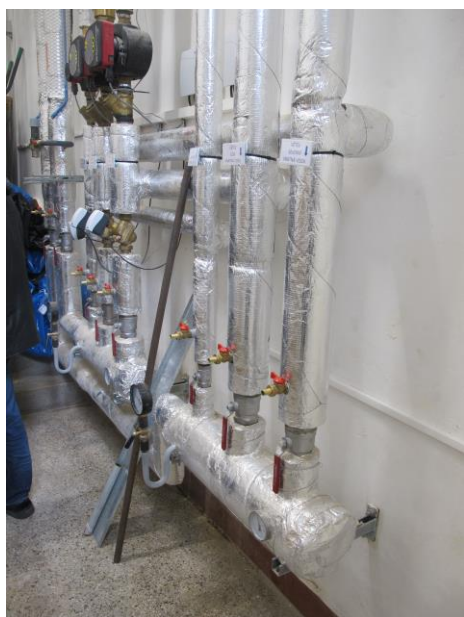
Foto č.7 – topné rozvody se složitou obnovou povrchových úprav
