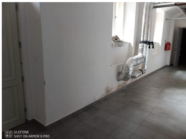
Foto č.17 – nedostatečná úprava prostupového potrubí ve spojovací chodbě z dvorního prostranství
