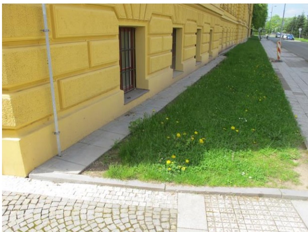
Foto č.5 – okapový chodník s travní úpravou podél ulice Šimkova
